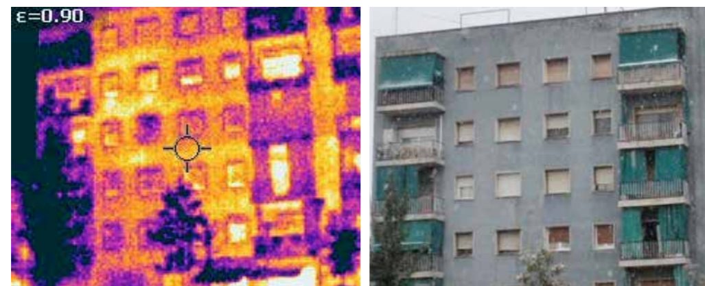
Bloque 2 barrio Congost. Fachadas. Fuente.- CENER
