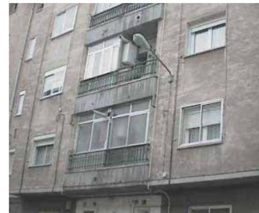
Detalle de los sistemas de calefacción. Fuente.- CENER
