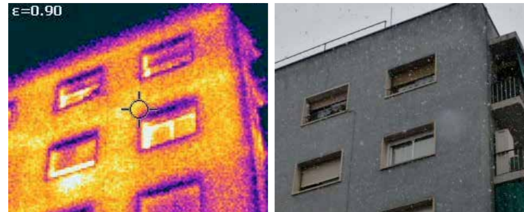
Bloque 2 barrio Congost. Fachadas. Fuente.- CENER
