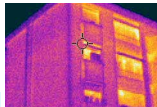
Bloque 1 Can Bassa. Fachada oeste. Fuente.- CENER
