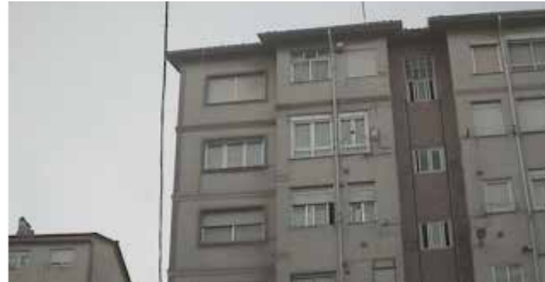
Barrio de San Francisco. Termografía. Tipología I. Vista general. Fuente.- CENER
