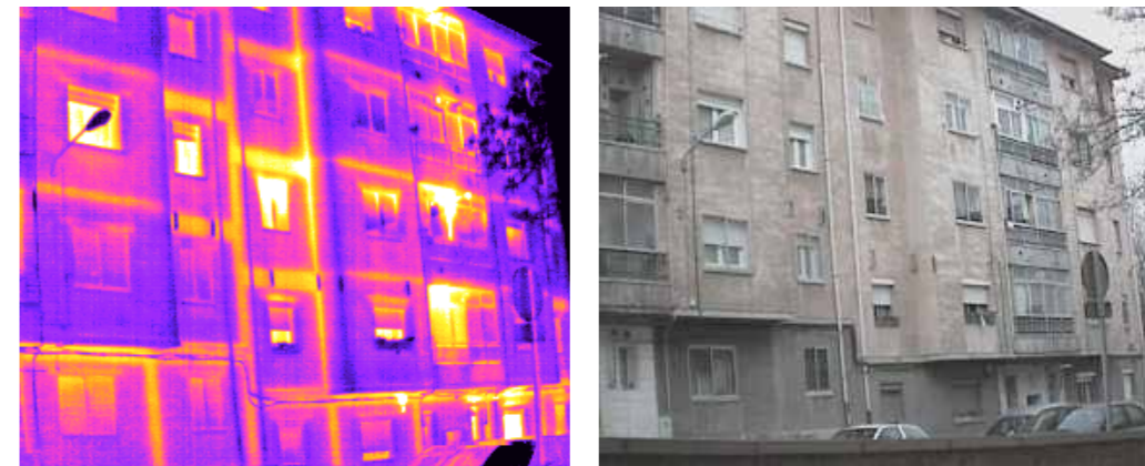
Detalle de los forjados. Fachada Este. Fuente.- CENER
