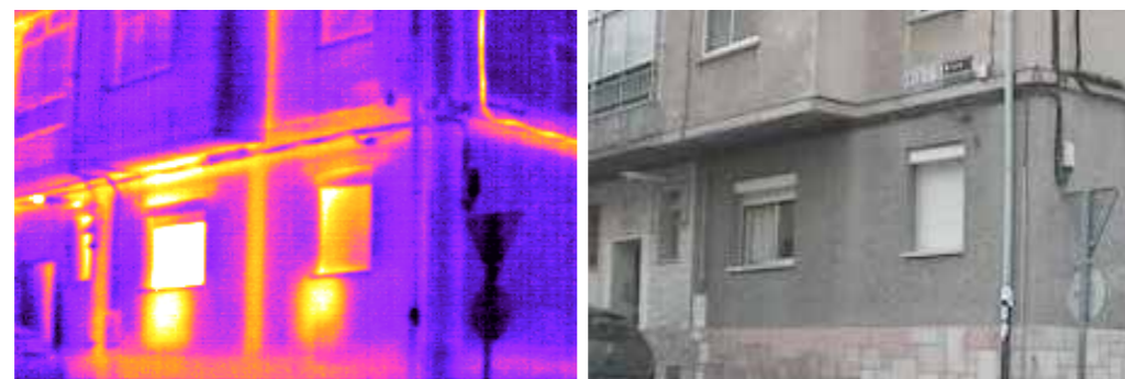
Radiadores en vivienda. Fuente.- CENER
