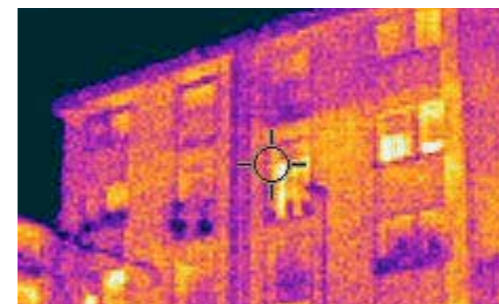
Bloque 1 Can Bassa. Fachada Este. Fuente.- CENER
